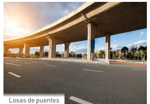
Losas de puentes
