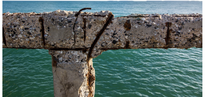
Estructura con varilla de acero.
