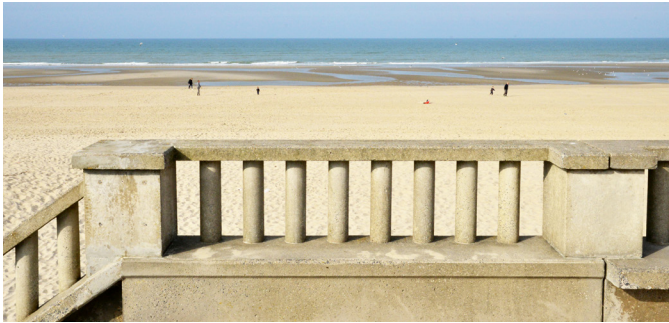
Estructura con varilla de fibra de vidrio.
